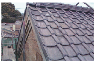
瓦を敷き直しました
